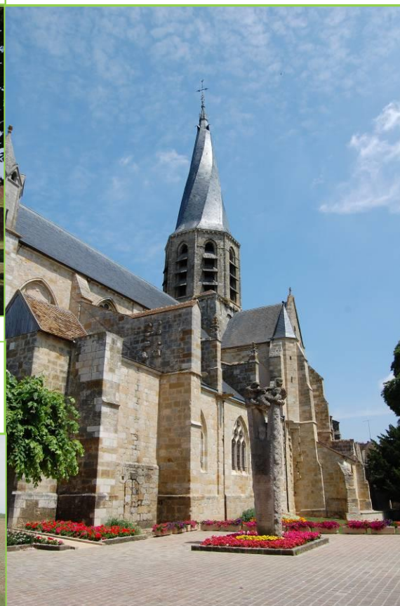
Eglise de Puiseaux (cliché : PGBP)
