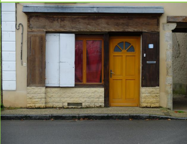
Commerce transformé en logement à Boynes (cliché : Terres Neuves)
