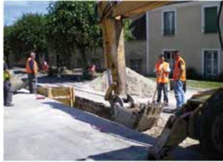
Travaux de création du réseau d'Aulnay la Rivière - 2011
