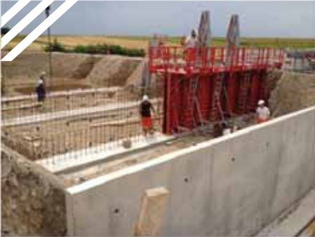
Travaux de création de la STEP d'Autruy sur uine - 1 150 EH - 2012
