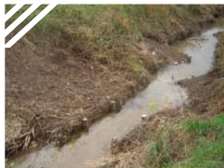
Travaux de renaturation légère sur le secteur de Chemault (Rimarde, tranche 2 – 2011)
