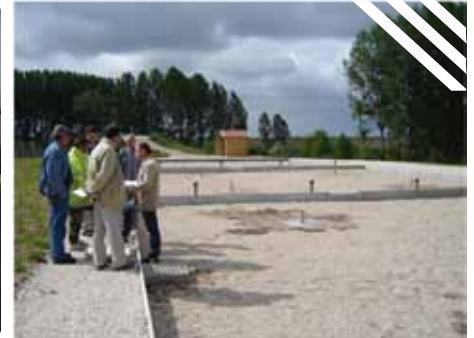
Réception des travaux de la STEP de Courcelles - 490 EH - 2009
