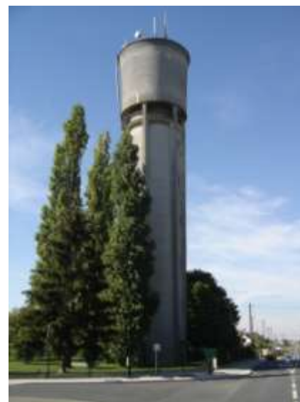
Château d'eau de Chilleurs aux Bois
