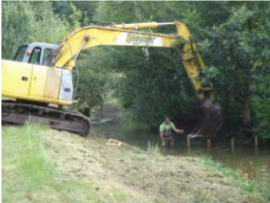
Mise en place des déflecteurs sur le premier tronçon
