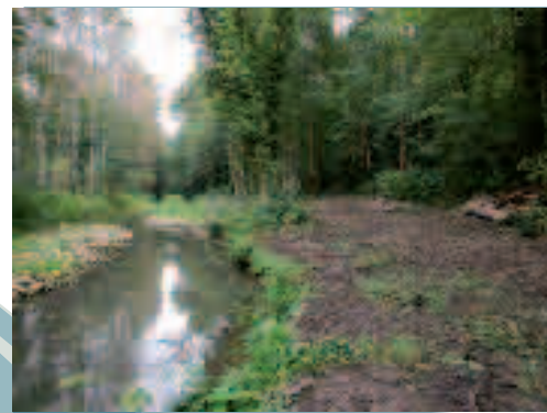
Travaux de restauration de la Rimarde – Yèvre la Ville
