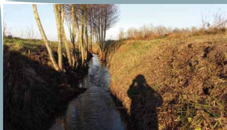
Travaux de restauration de la Petite Rimarde à Chambon
