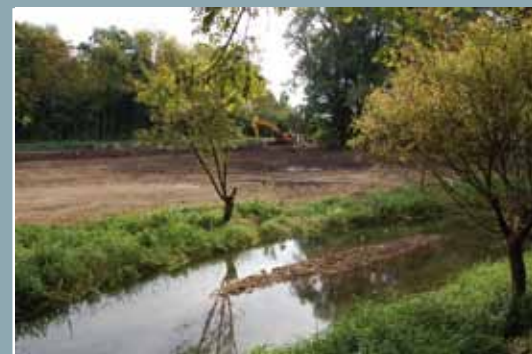
Travaux de restauration de l'Œuf – Pithiviers le Vieil
