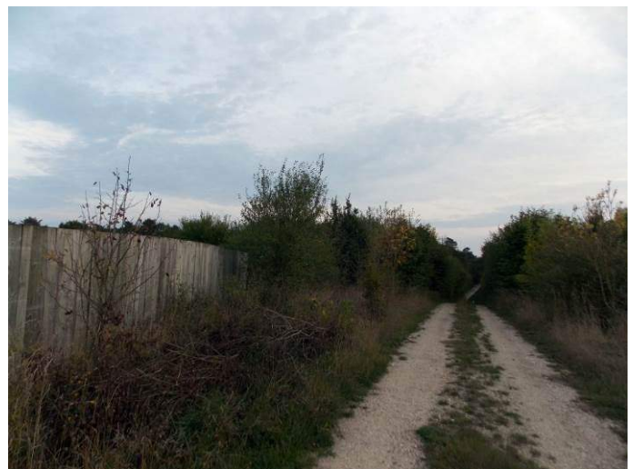
Vue sur le tablier végétalisé du passage supérieur.
