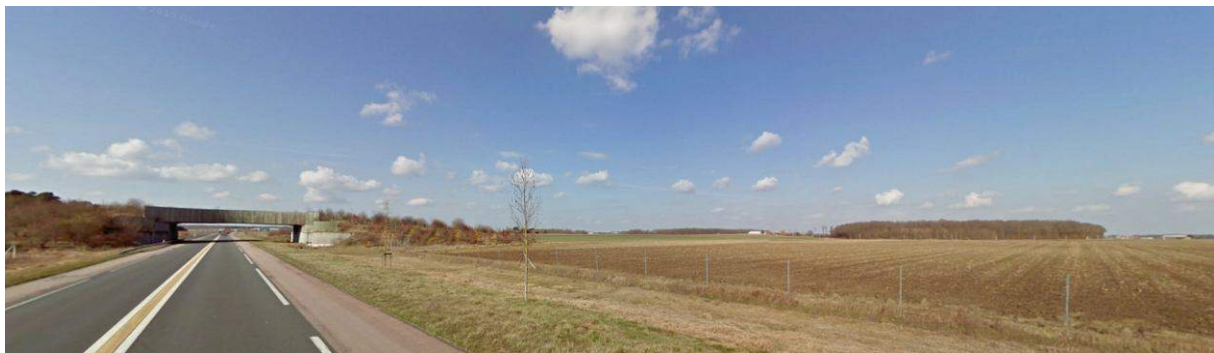
Vue sur le passage supérieur, les cultures et le Bois Palot depuis la D2060 (© Google)
