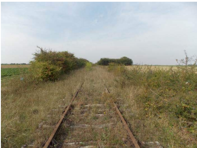
Voie ferrée enherbée encadrée ponctuellement de haies à hauteur de Sermaises
