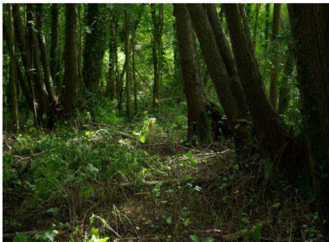
Source des Grès : avant travaux. © SMOE.
