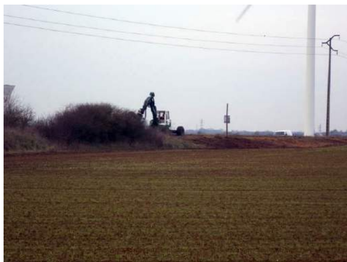
Travaux lourds de défrichement d'une voie ferrée non exploitée en hiver à proximité d'Audeville.
