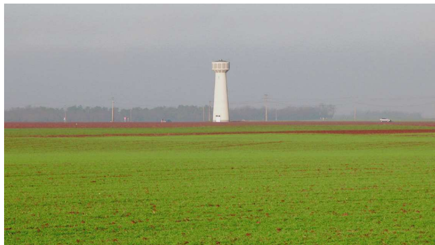
Château d'eau, élément de repère dans un paysage ouvert
