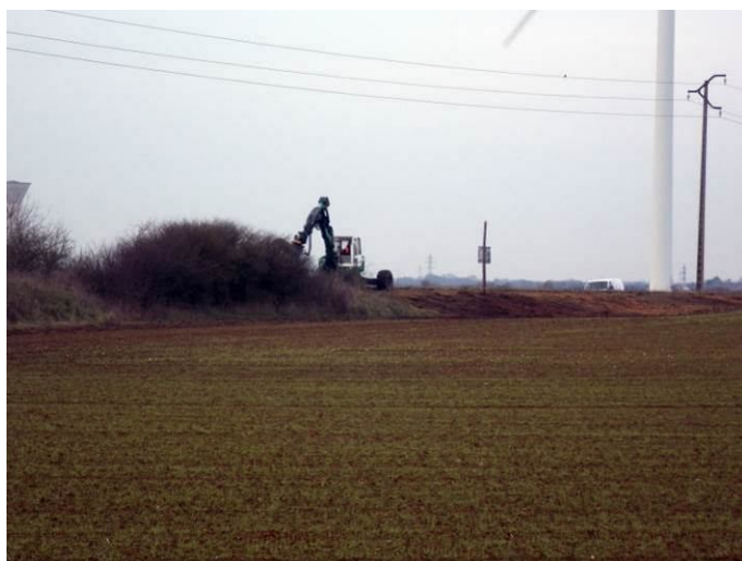
Travaux lourds de défrichage d'une voie ferrée non exploitée en hiver à proximité d'Audeville.
