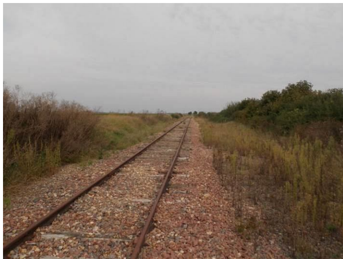
Voie ferrée exploitée au ballast nu encadrée ponctuellement de haies aux environs d'Estouy
