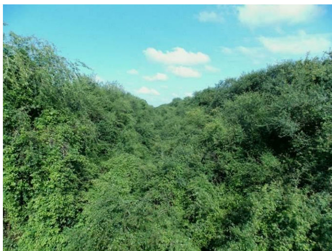
Voie ferrée en déblai non exploitée complètement envahie par la végétation arbustive à Sermaises
