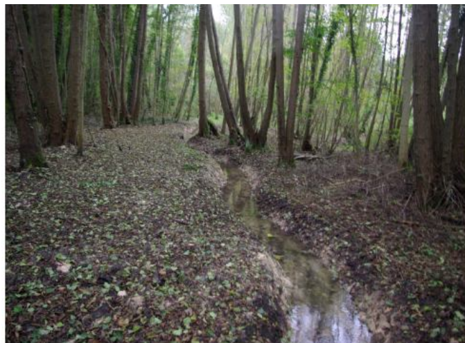
Source des Grès : après travaux © SMOE.
