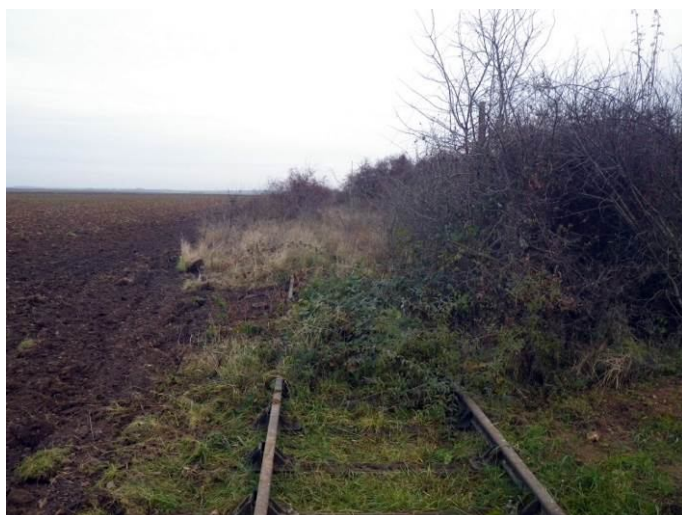
Emprise de voie ferrée non exploitée enfrichée et « grignotée » par un exploitant agricole à Estouches
